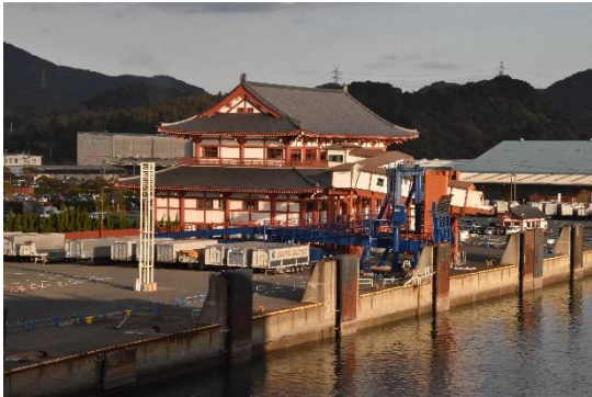
阪九フェリーの神戸航路用のターミナルビルです。
